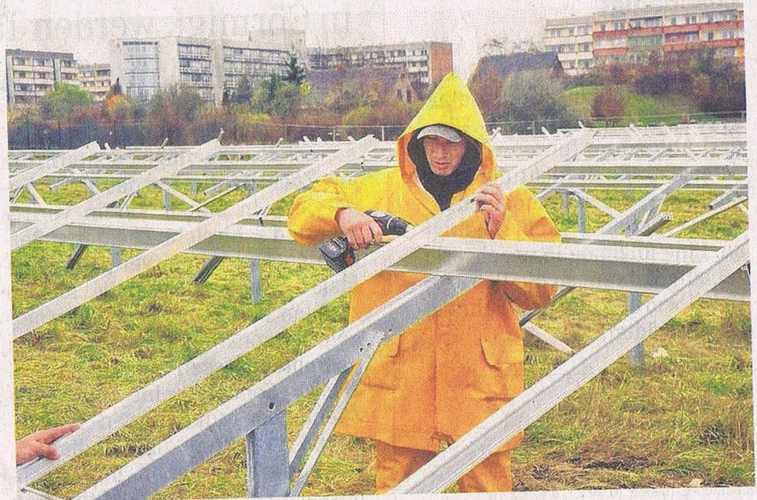
Alles ist fertig für den Anbau der Module in der Nähe von McDonald's.
